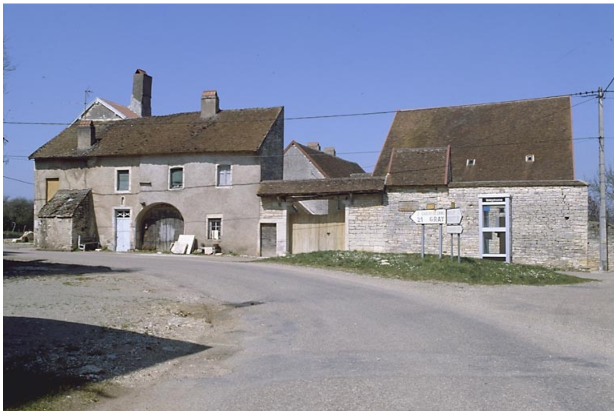
Vue d'ensemble après destruction du bâtiment agricole.
