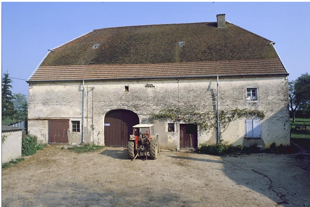
Façade sur cour.
