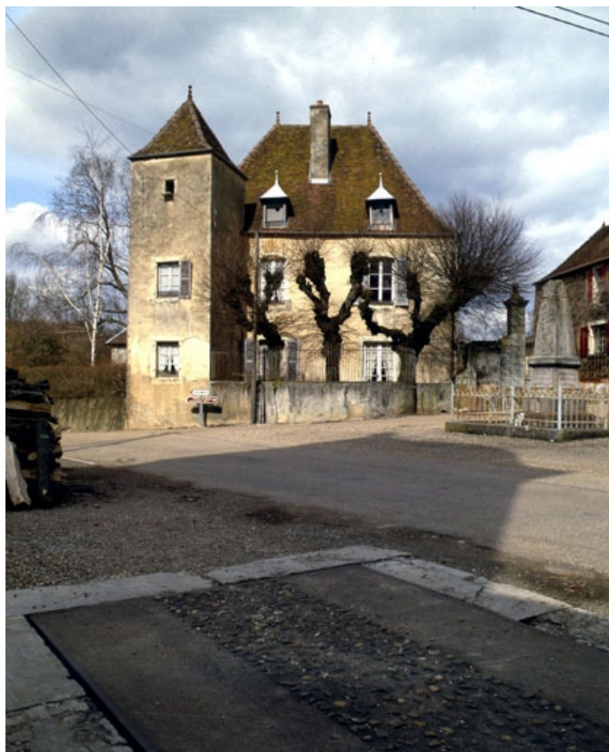
Vue d'ensemble depuis la rue.
