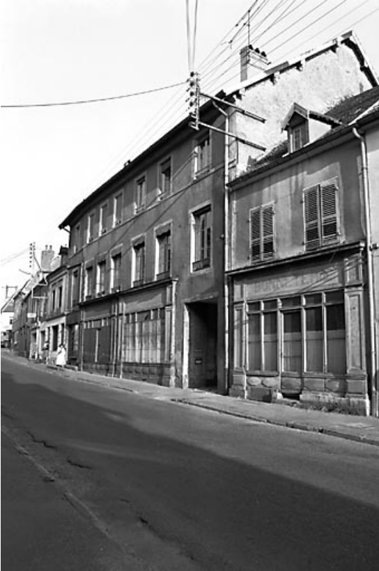
Façade antérieure avec magasins au rez-de-chaussée.
