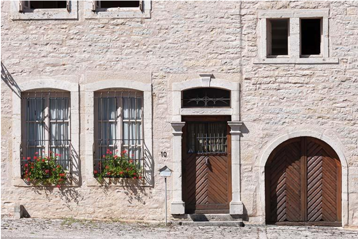
Détail des baies de la façade sud
