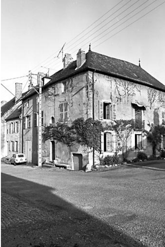
Façades antérieure et latérale droite.
