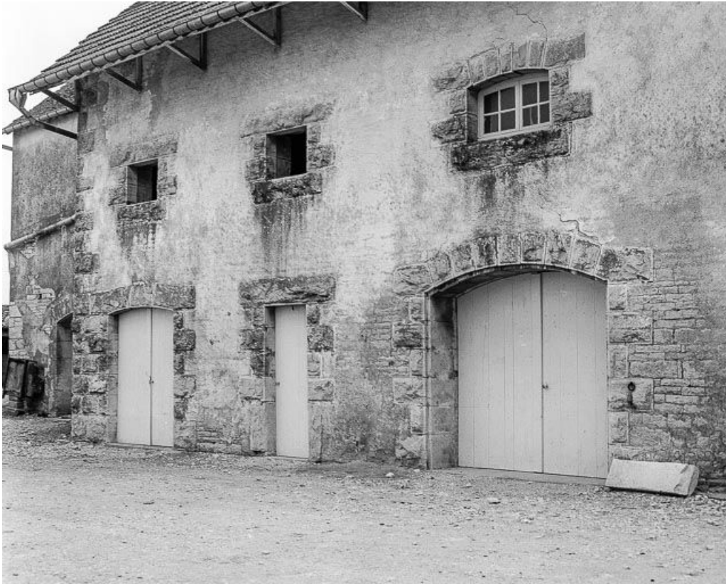
Partie agricole : détail de la façade postérieure.
