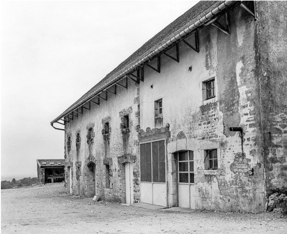
Partie agricole : façade postérieure.
