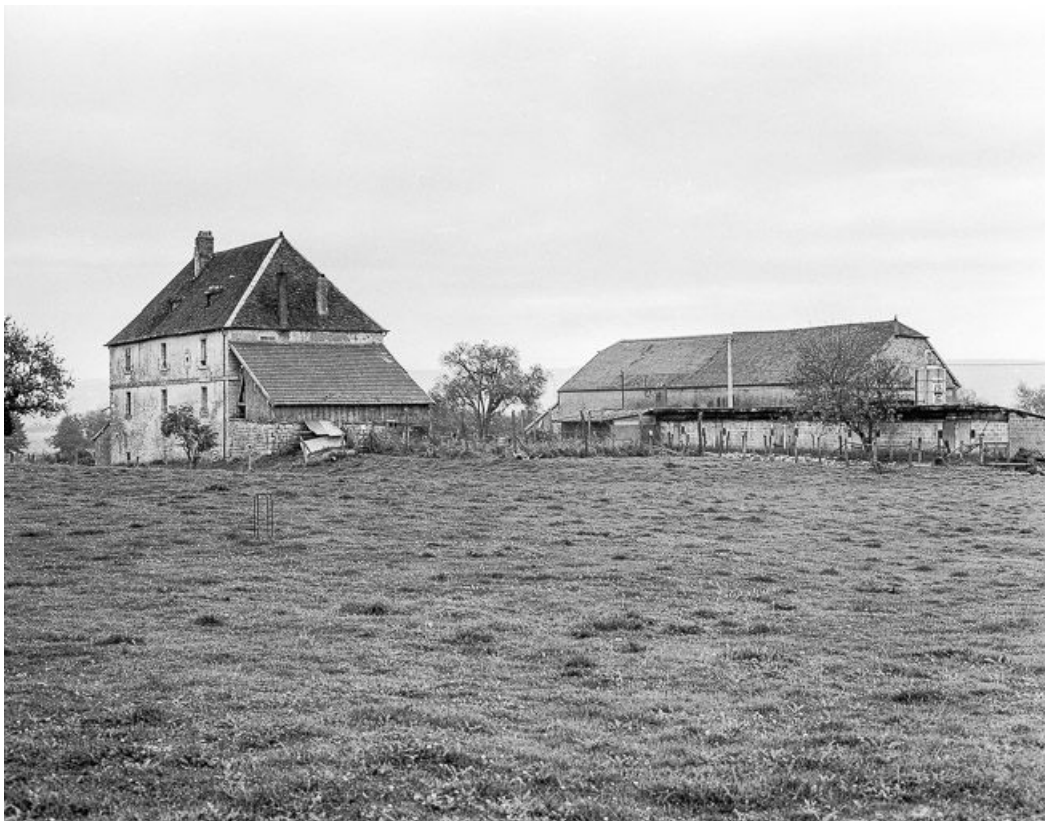
Façades postérieure et latérale droite.
