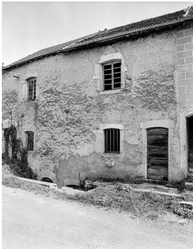
Vue d'une façade.
