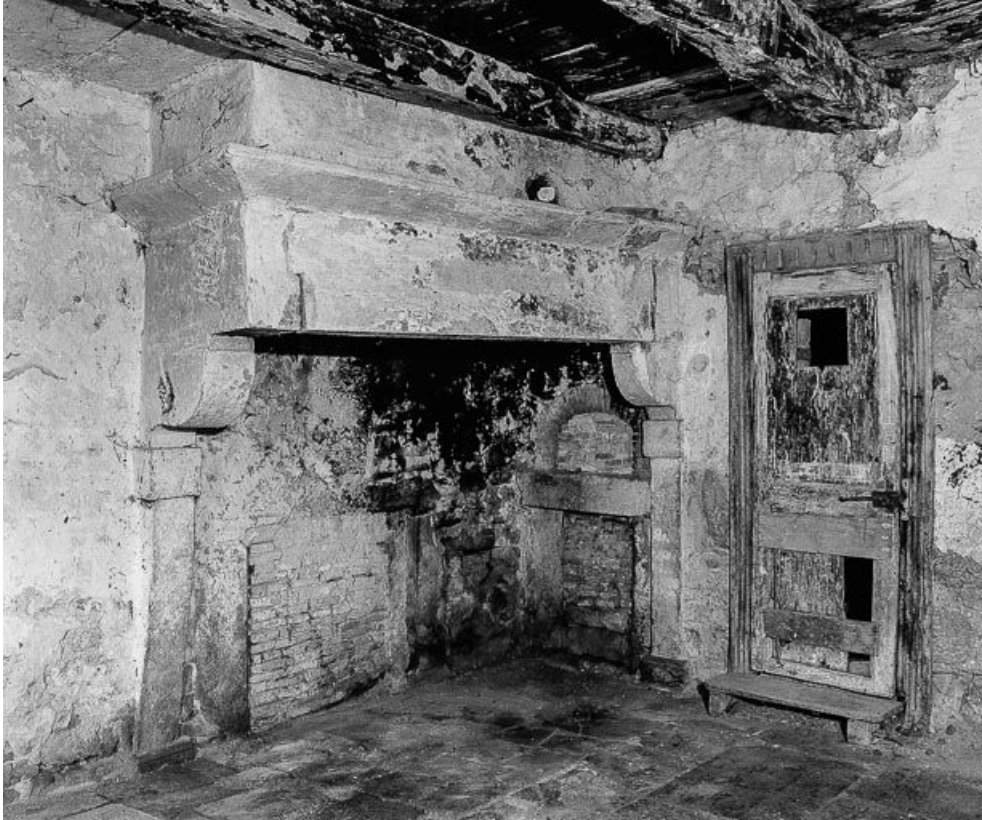
Intérieur : cheminée de la cuisine.
