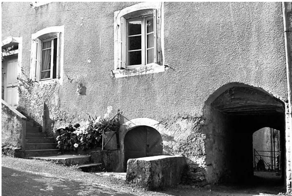
Vue du rez-de-chaussée.
