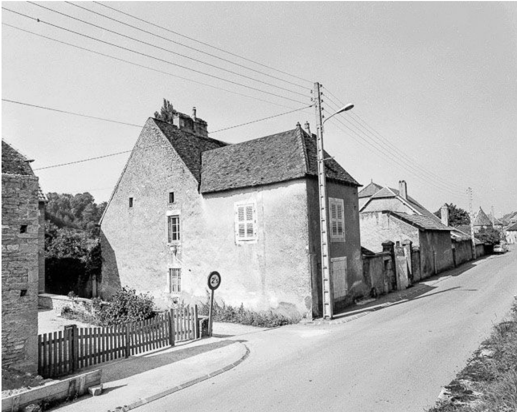
Façade latérale gauche.
