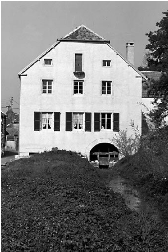
Façade latérale droite.
