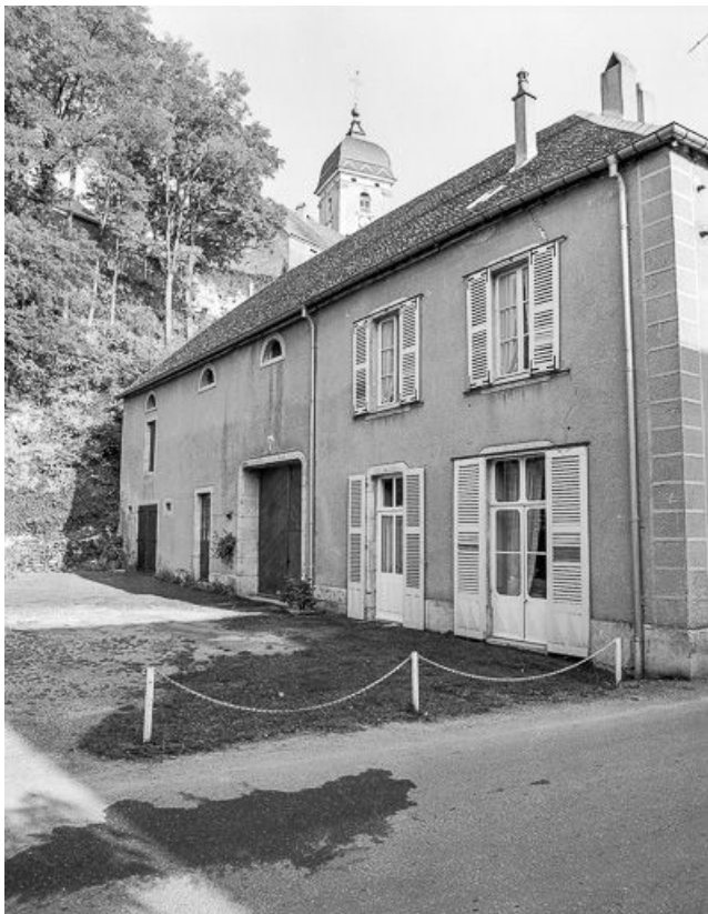
Façade latérale gauche.
