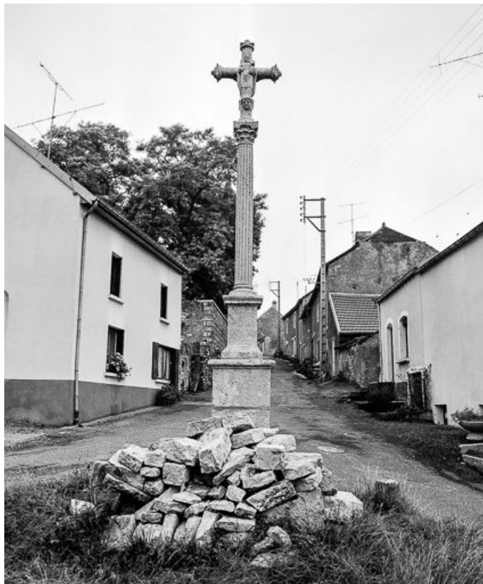
Vue d'ensemble : face postérieure.
