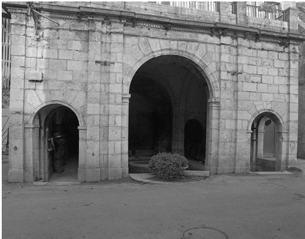
Façade antérieure : détail du rez-de-chaussée.
