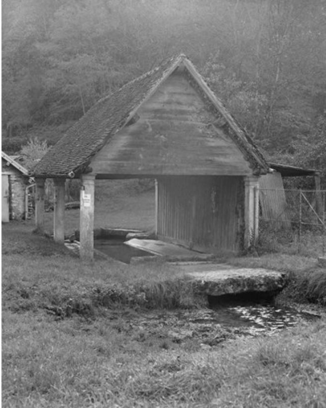
Vue d'ensemble avec le déversoir.
