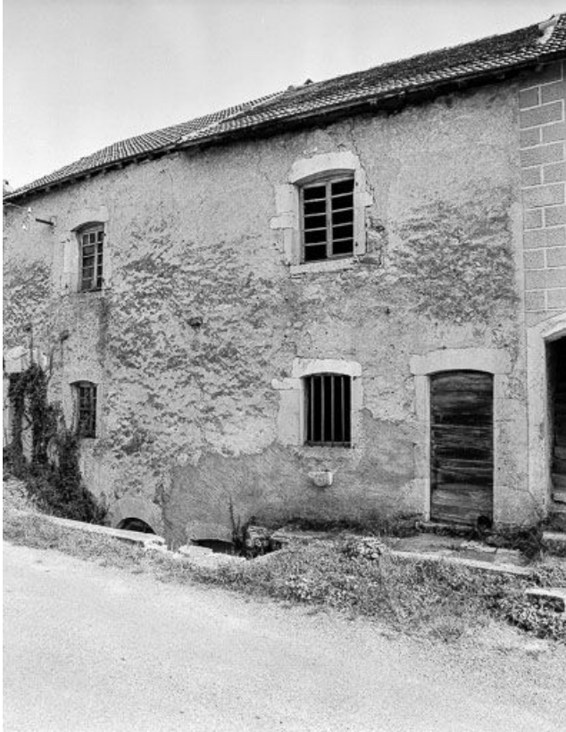
Vue d'une façade.
