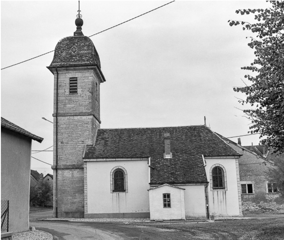
Extérieur : façade latérale droite.
