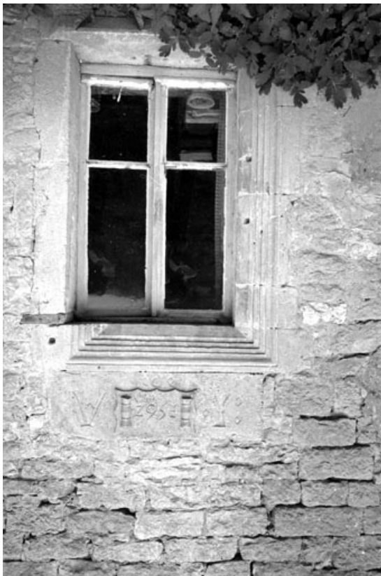
Détail de la façade postérieure.
