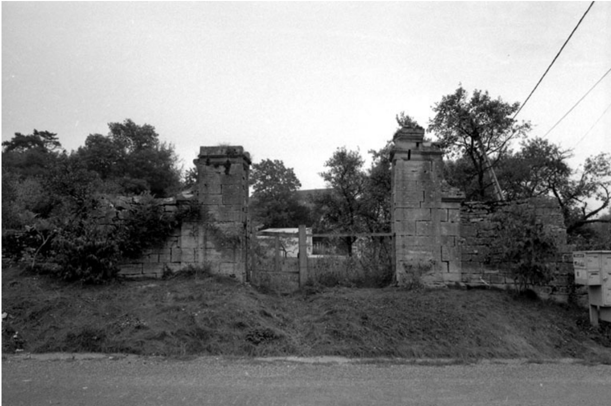
Vestige du portail du château.
