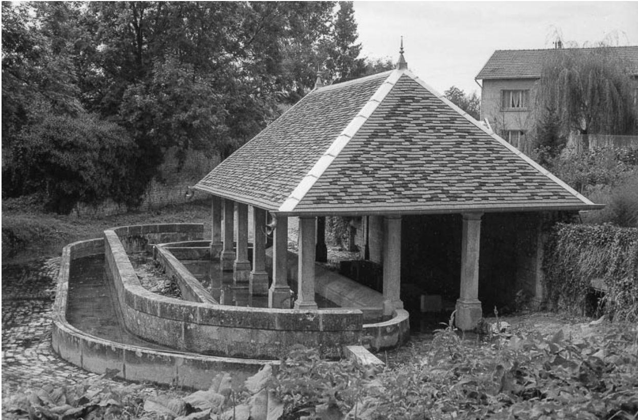
Façades antérieure et latérale droite en 1979. 70, Pin
