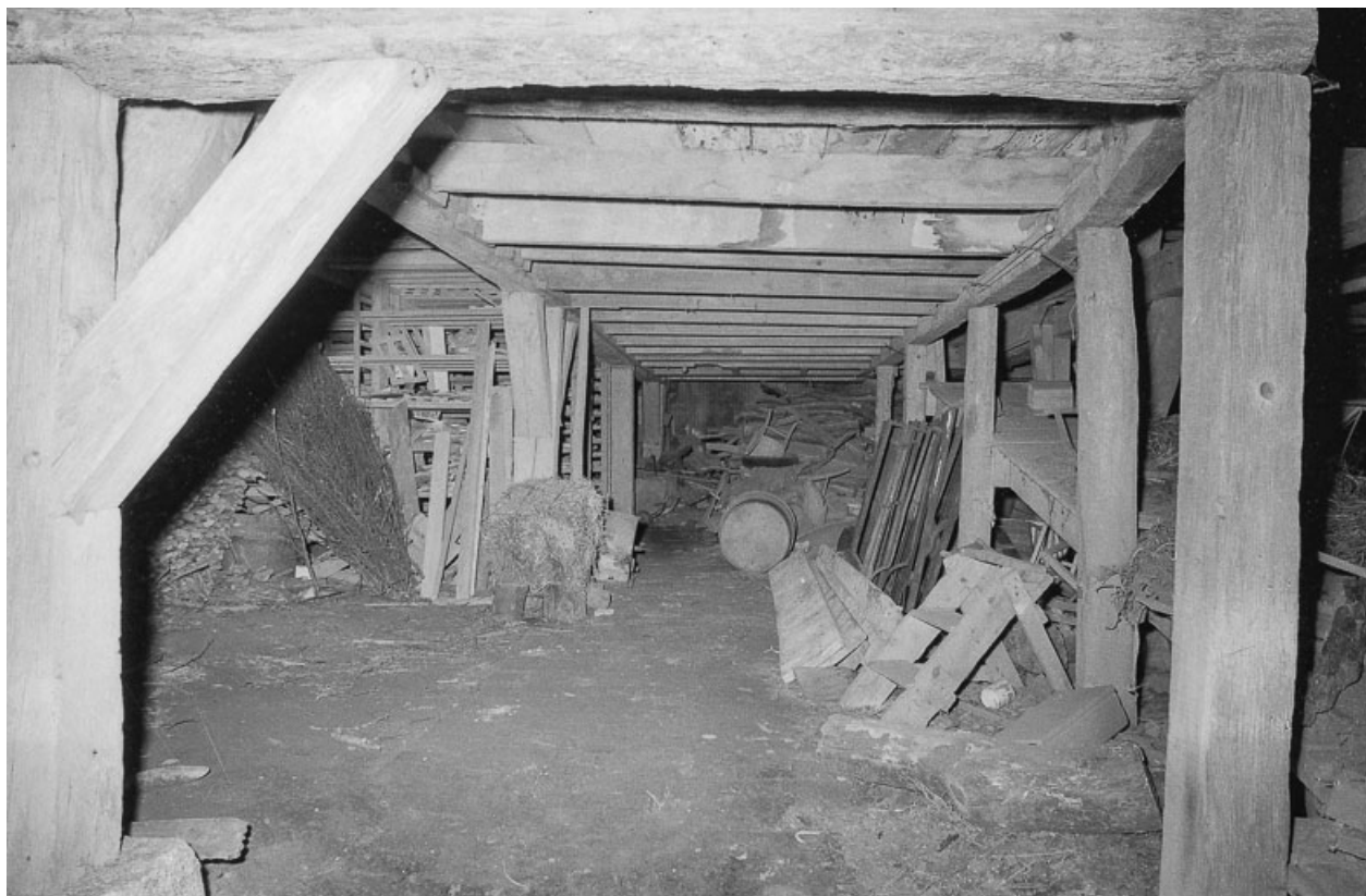
Intérieur du séchoir.
