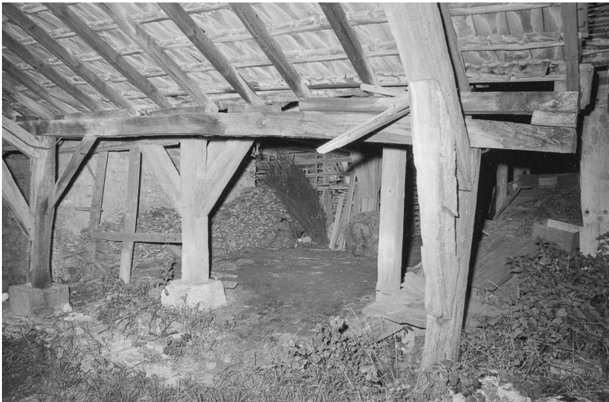
Intérieur du séchoir.
