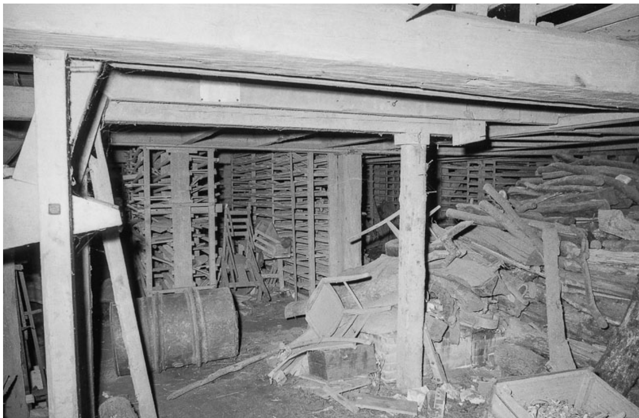
Intérieur du séchoir.
