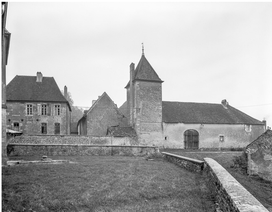
Vue d'ensemble de la partie gauche.
