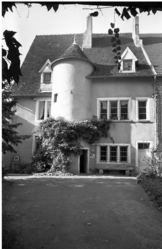
Façade antérieure sur cour : partie gauche.
