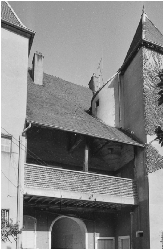
Façade sur cour.
