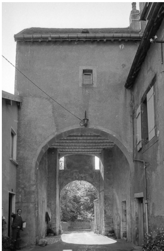
Ouvrage d'entrée : façade sur cour.
