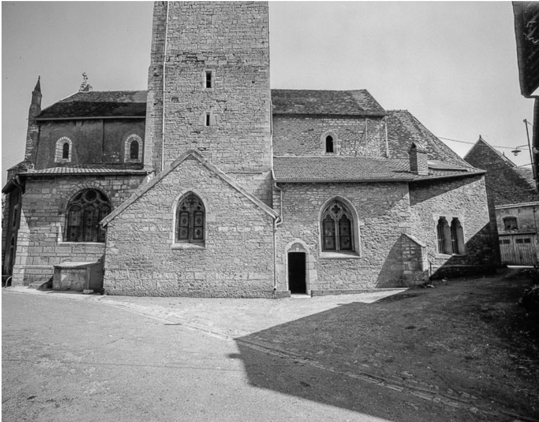
Façade latérale droite.
