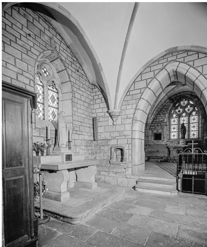
Bas côté gauche (avant la chapelle gauche).
