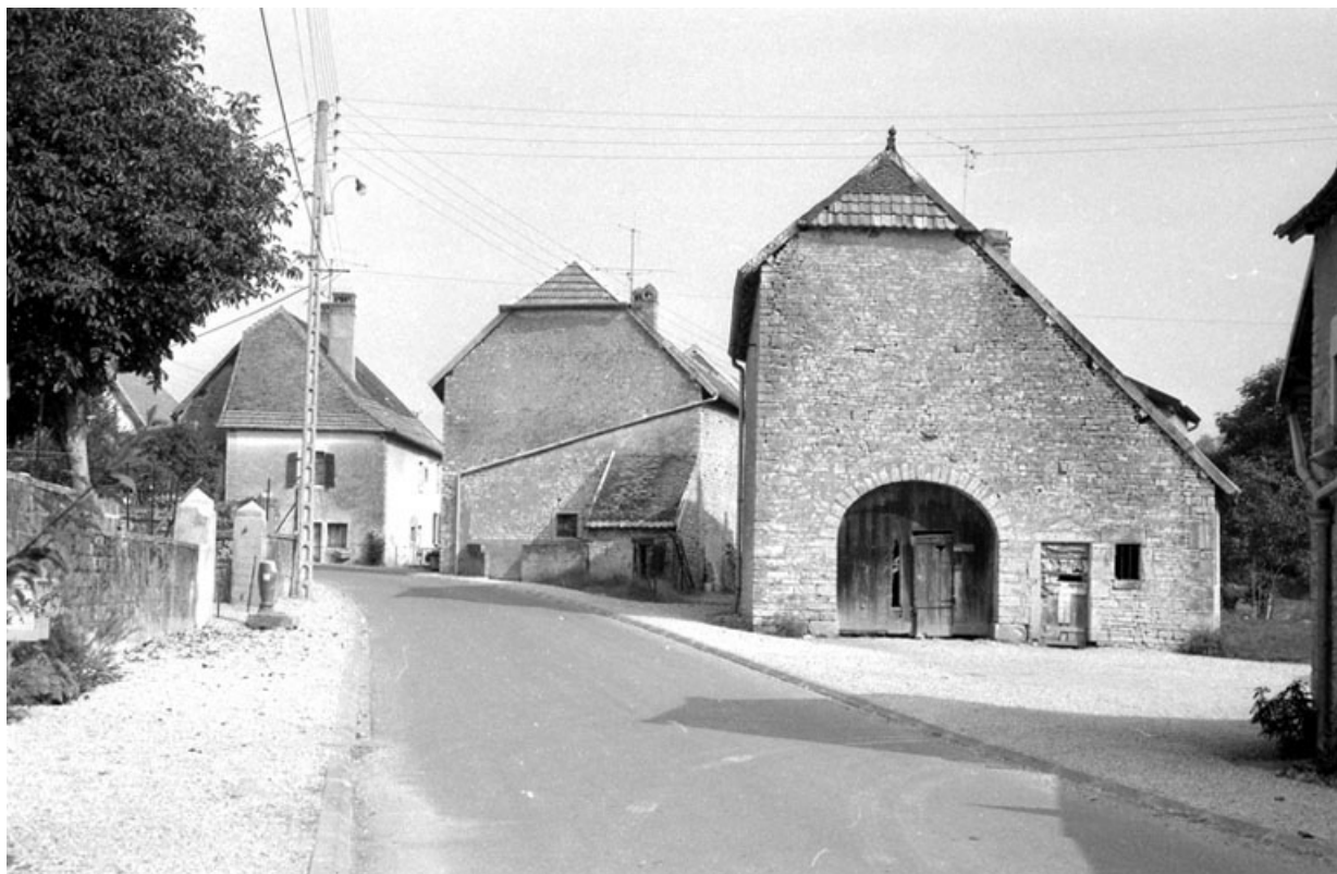
Façade latérale droite.
