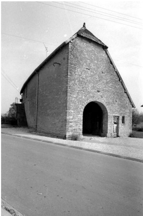
Façades antérieure et latérale droite.
