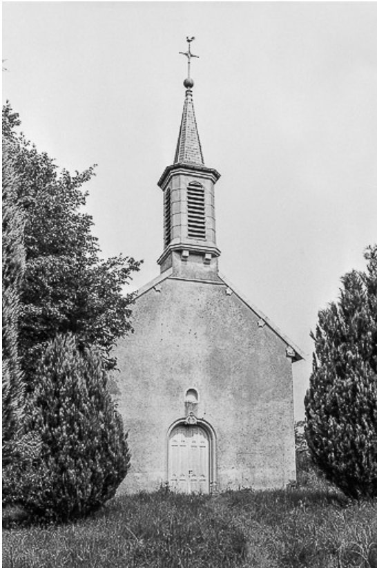
Extérieur : façade antérieure.
