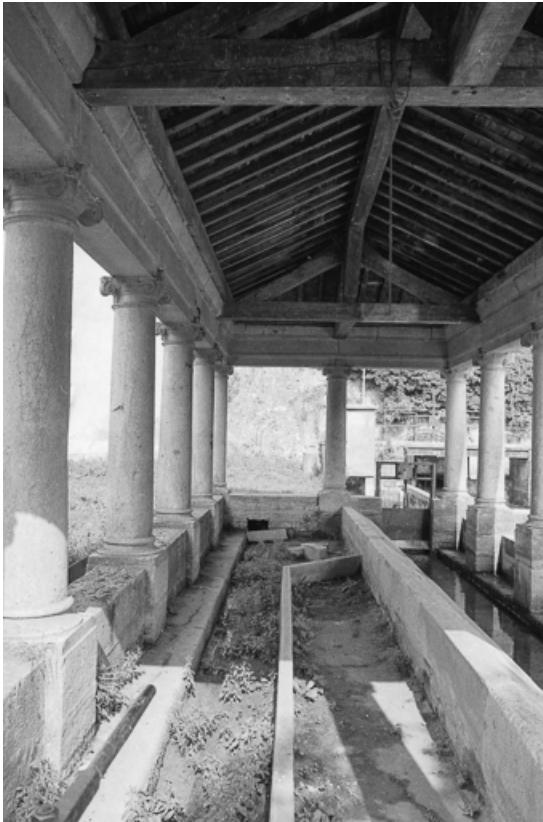
Intérieur : vue d'un bassin.
