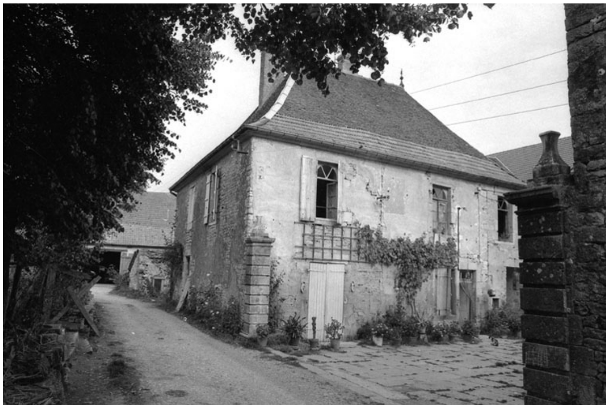
Façade sur cour de l'habitation gauche.
