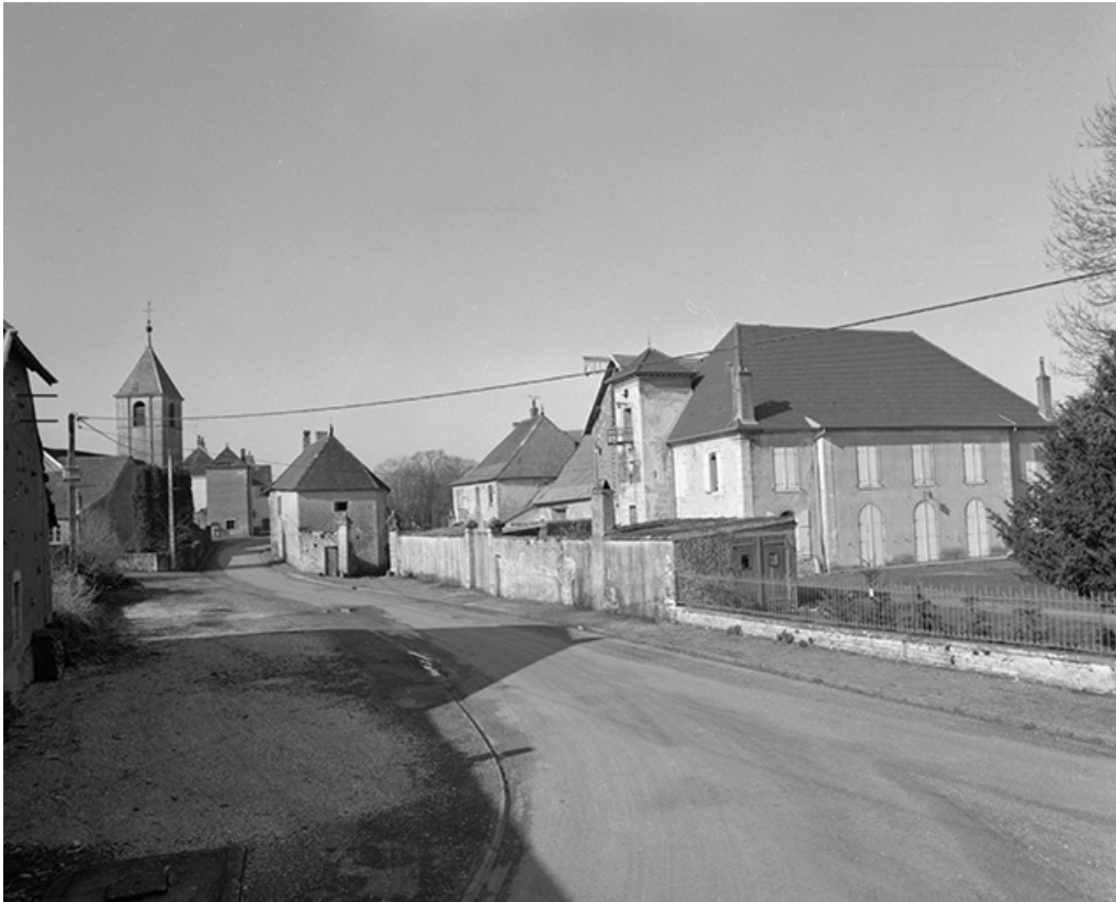
Vue d'ensemble depuis la rue.
