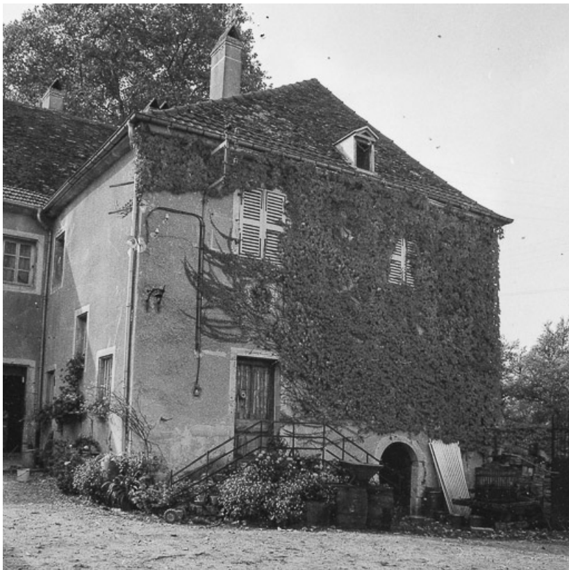
Habitation vue depuis la cour.
