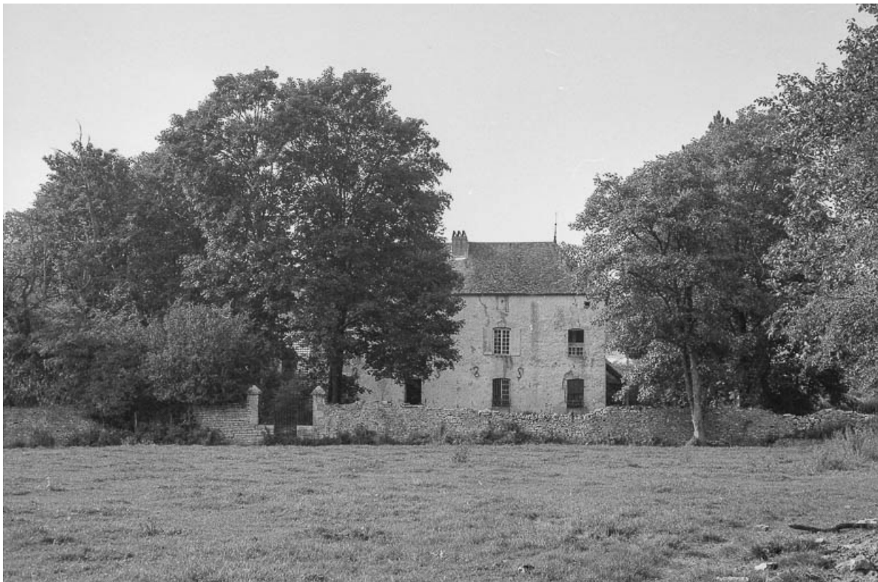
Façade sur le parc.
