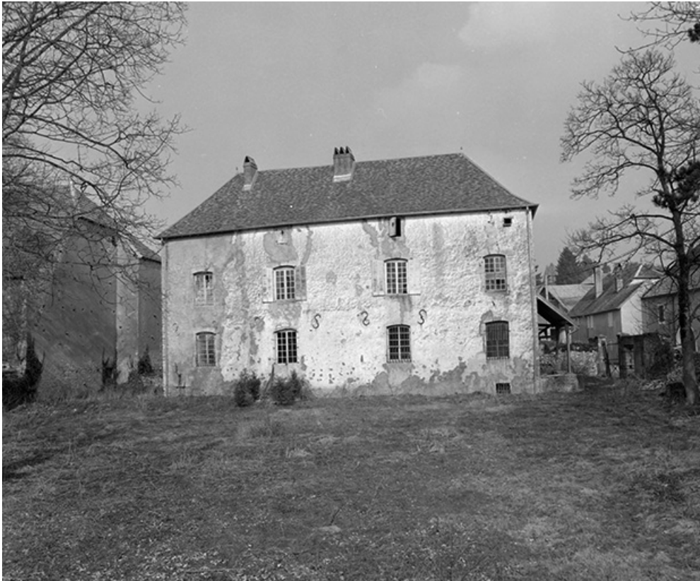
Façade sur le parc.
