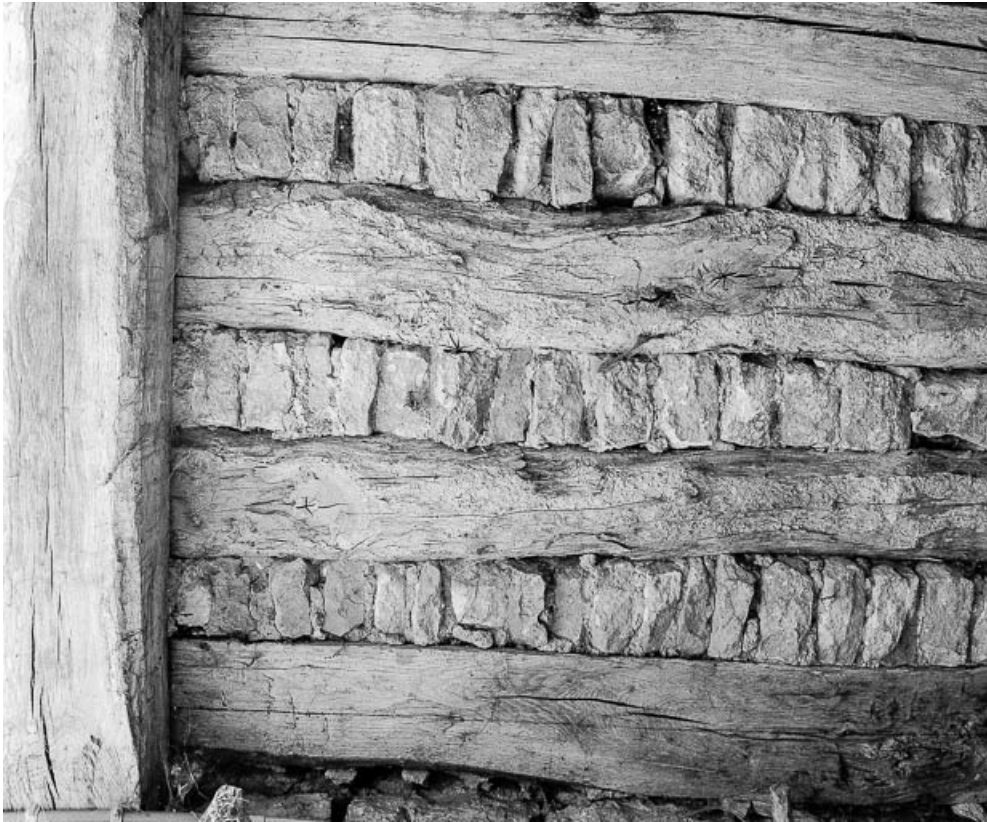
Plafond de la cave : hourdis de pierre.
