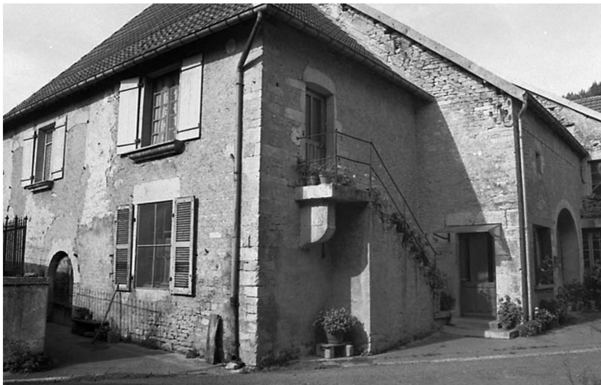
Façades antérieure et latérale gauche.
