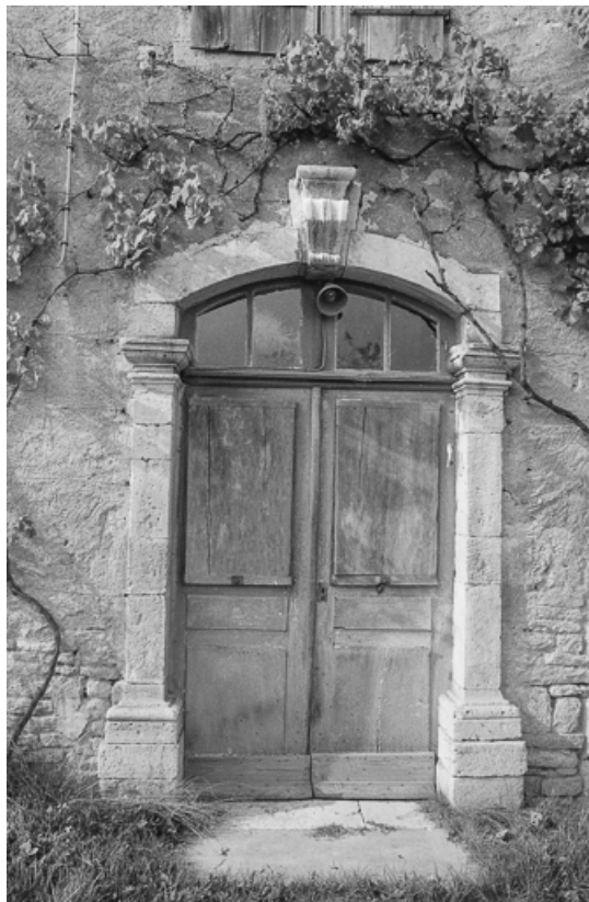
Détail : porte d'entrée de l'habitation.
