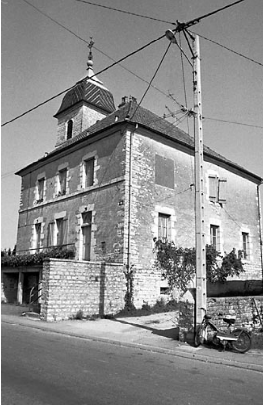
Façades antérieure et latérale droite.
