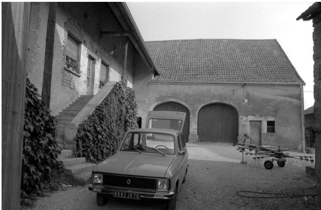
Bâtiment agricole dans la cour.
