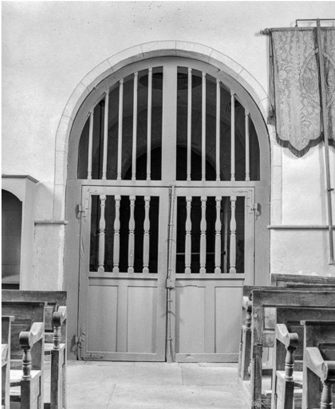
Intérieur : détail, porte d'entrée de la nef.
