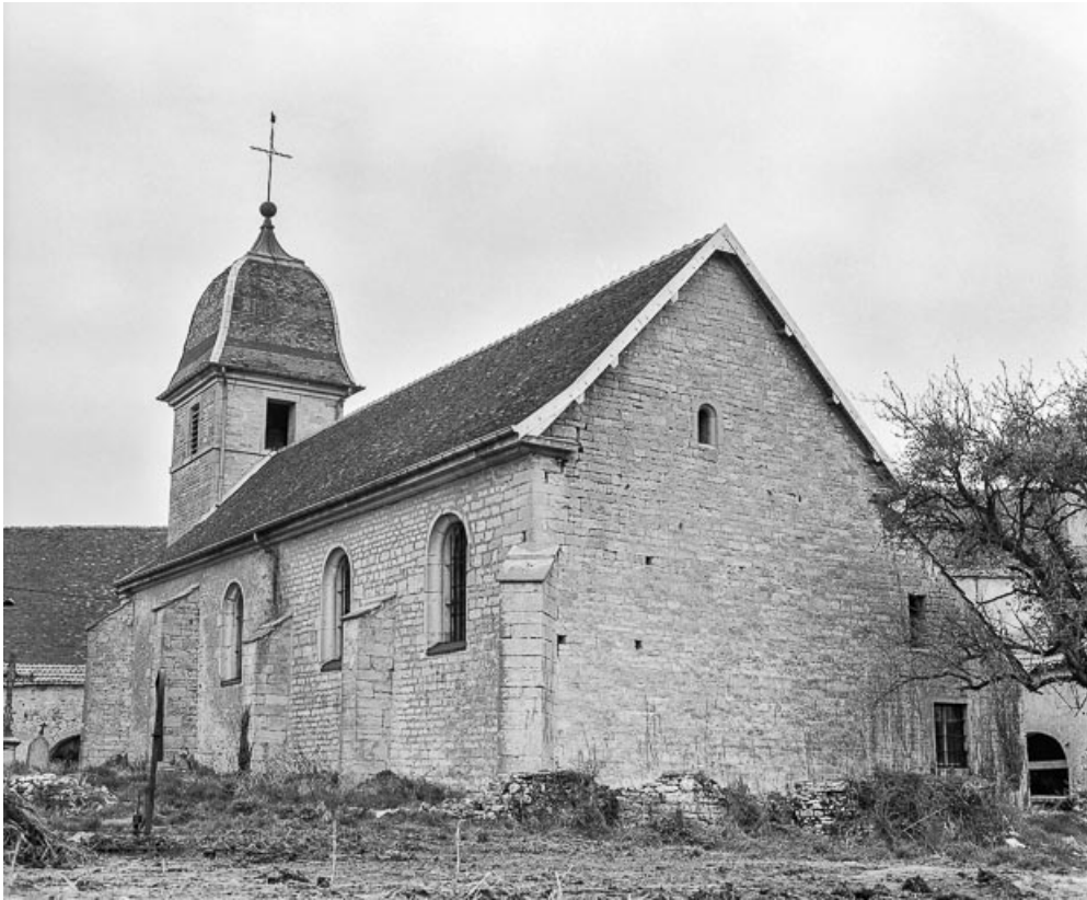
Façades postérieure et latérale droite.
