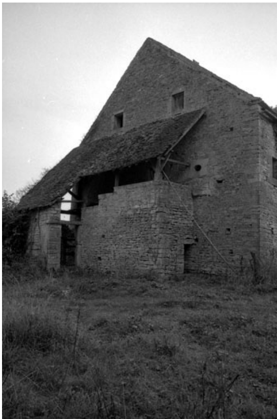
Façade latérale droite.
