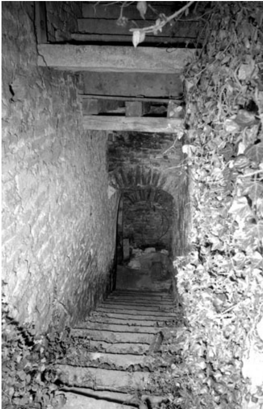
Partie habitation : escalier menant à la cave.
