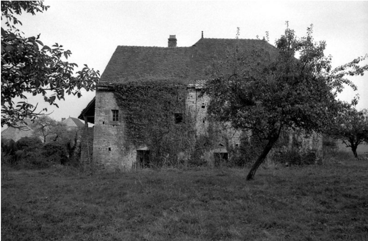
Façade latérale droite.
