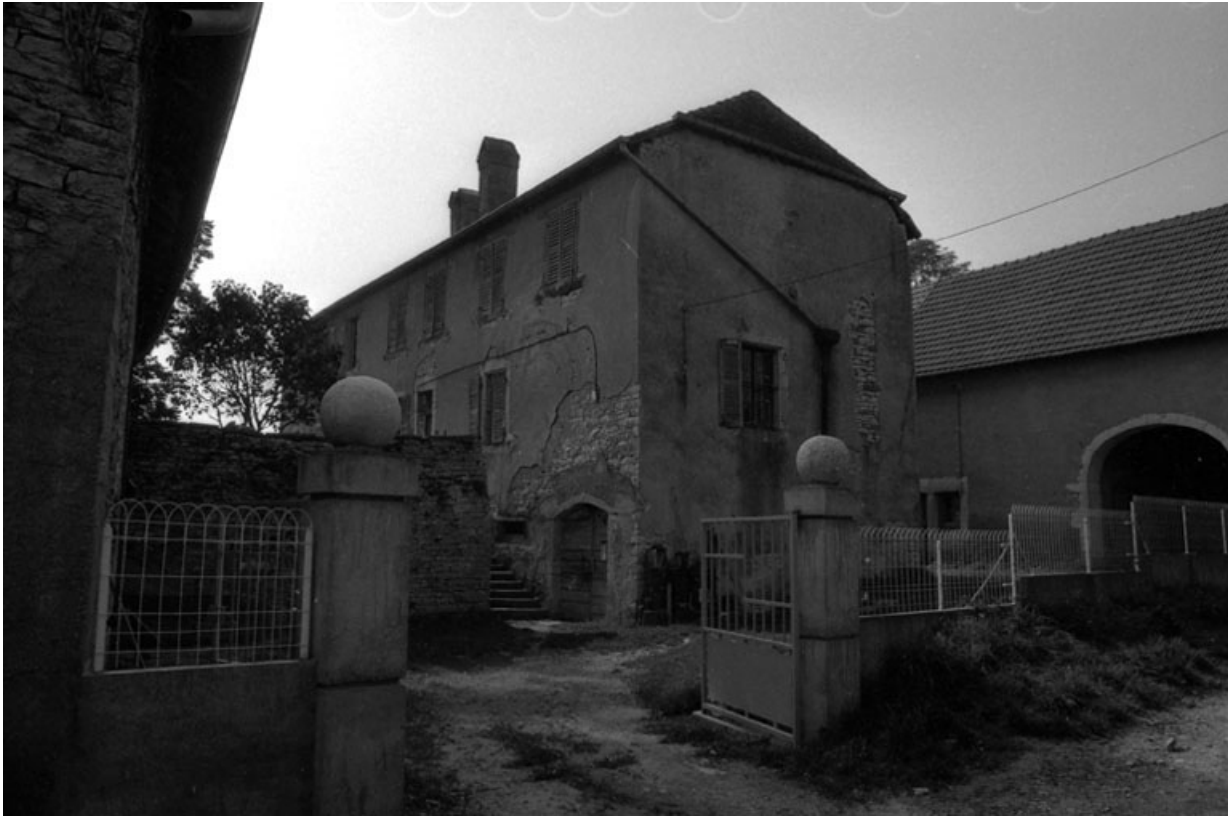
Maison d'habitation : façades antérieure et latérale droite.
