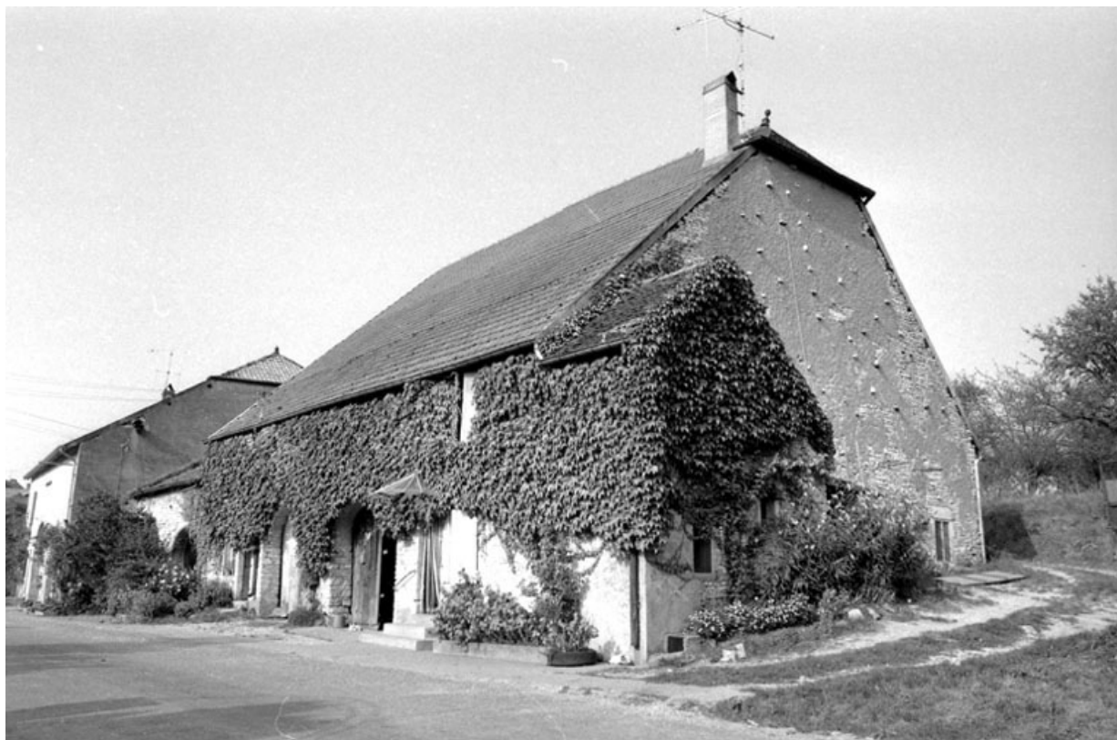
Façades antérieure et latérale droite.
