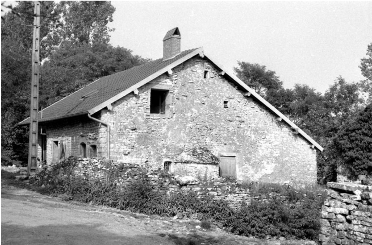
Façade latérale droite.
