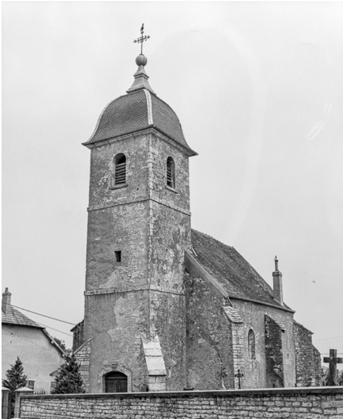
Façade antérieure et face latérale droite.
