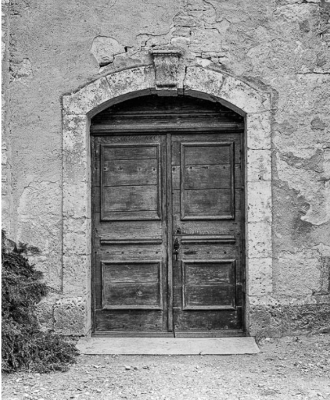
Façade antérieure : détail du portail d'entrée.
