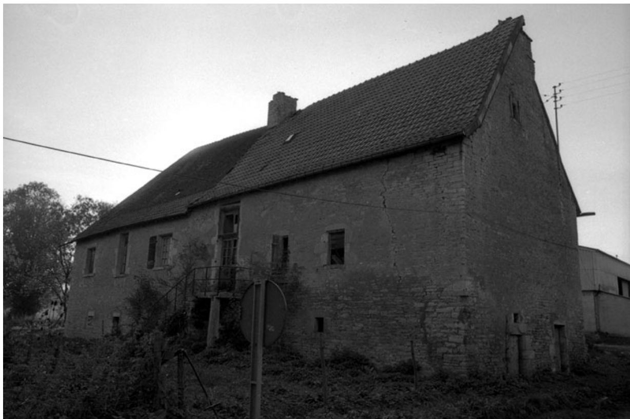
Partie agricole : façade postérieure.
