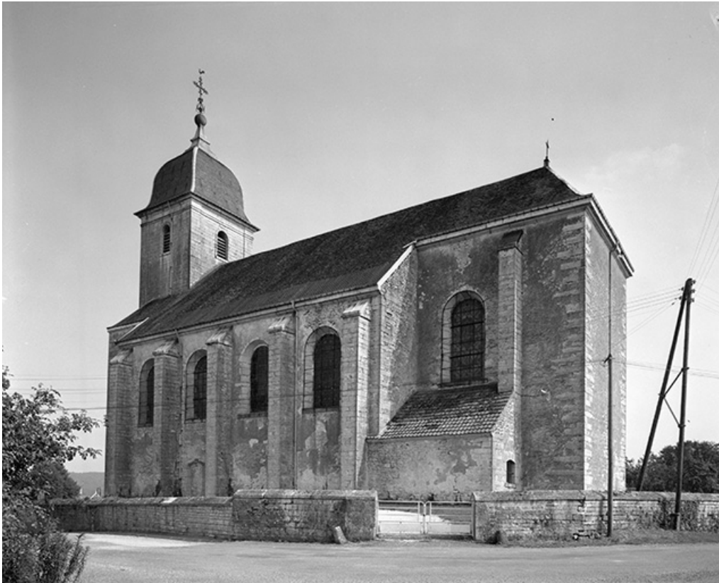
Façade latérale droite.
