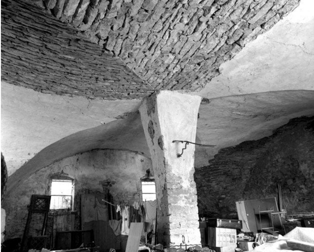
Pièce voûtée au rez-de-chaussée : la voûte.
