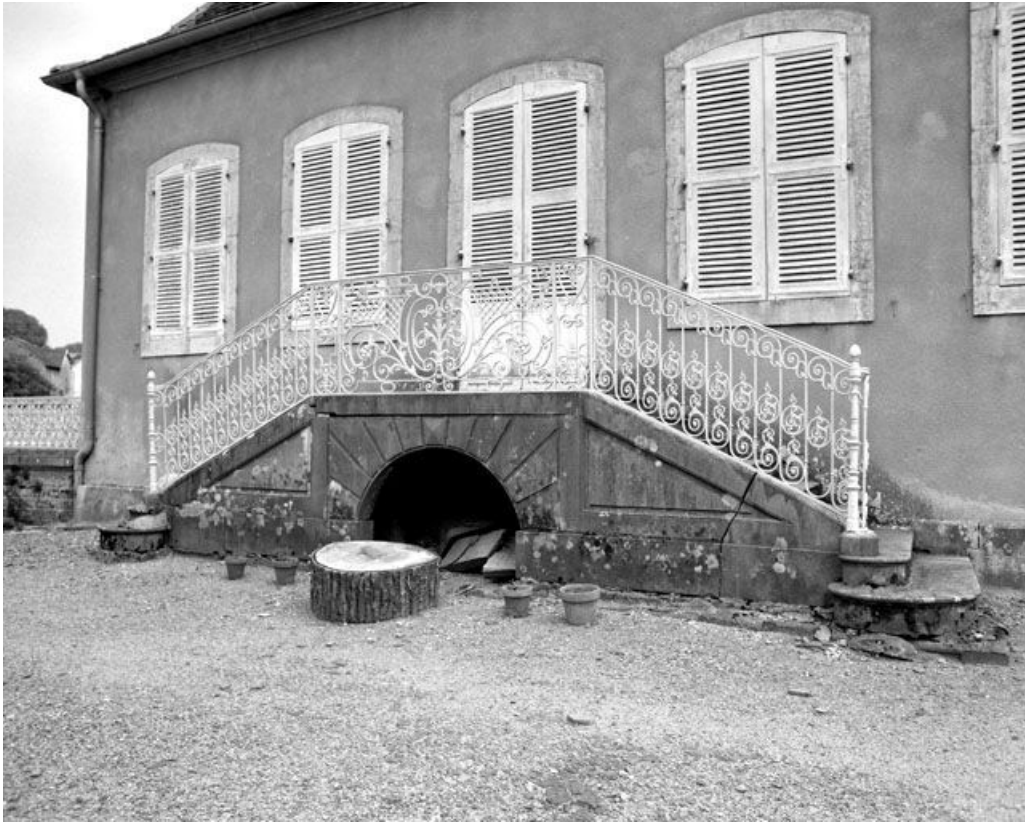
Façade droite du logis : détail du perron.
