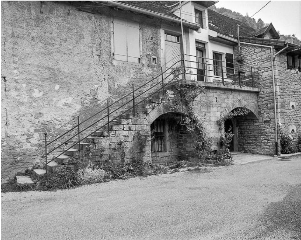
Façade antérieure : escalier à gauche de l'avancée.
