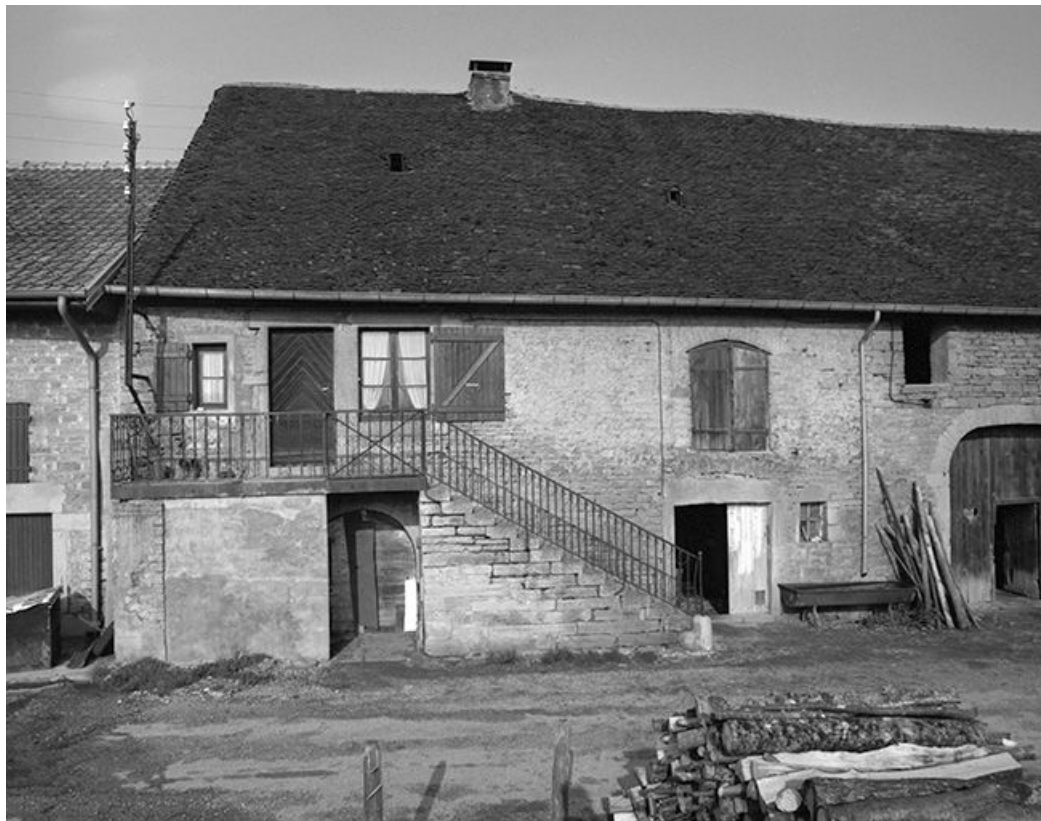
Façade antérieure : l'habitation.
