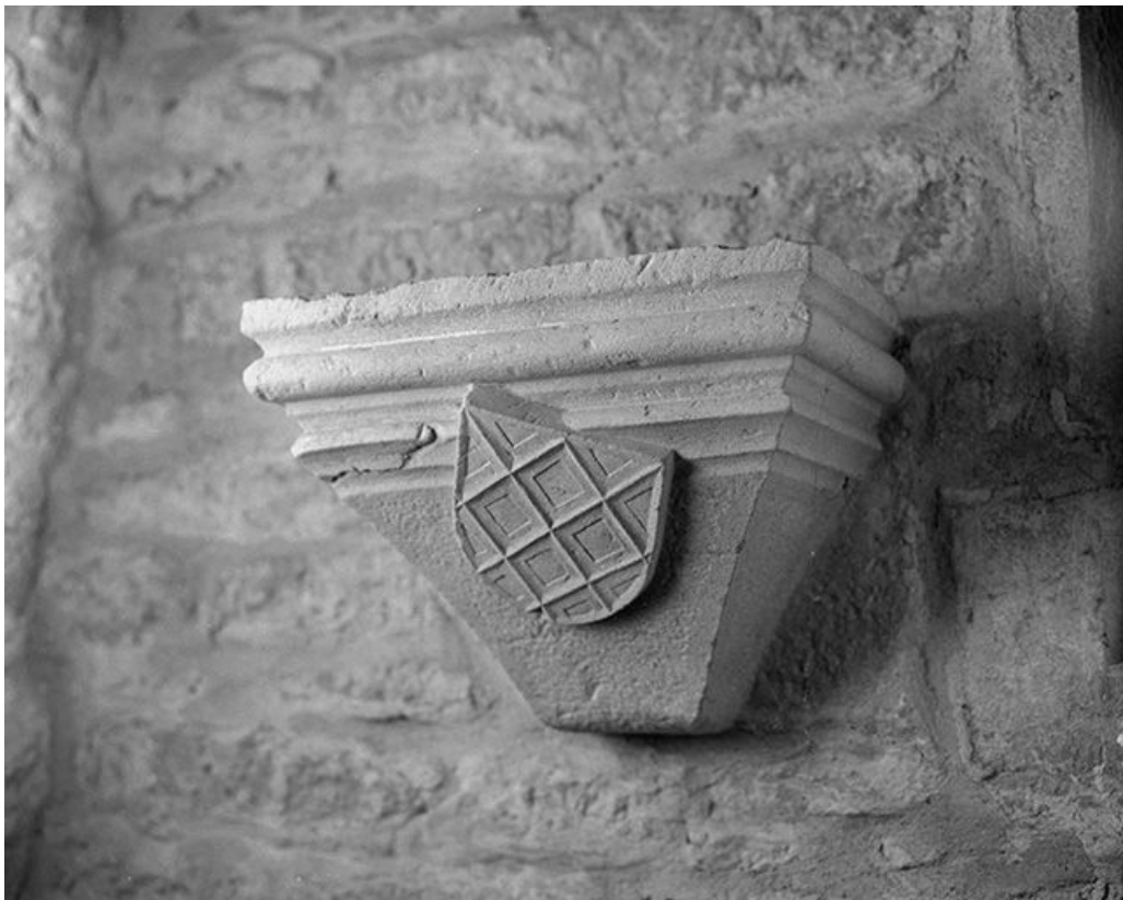
Intérieur : chapelle, mur est, console gauche.
